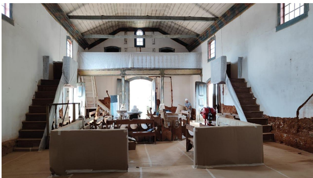
Legenda: Prospecções das alvenarias - Adobe Autoria: Francielle Ferreira Data: 10/04/2024
