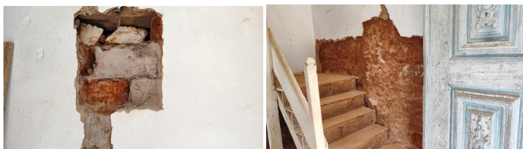
Legenda: Prospecções das alvenarias - Adobe Autoria: Francielle Ferreira Data: 10/04/2024
