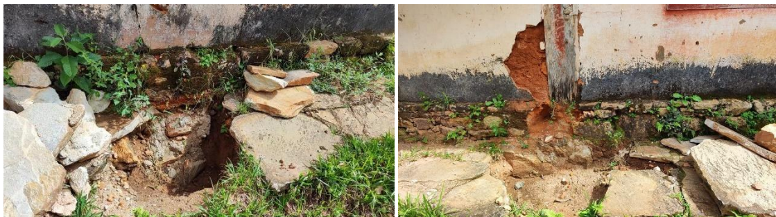
Legenda: Prospecções dos elementos estruturais Autoria: Francielle Ferreira Data: 10/04/2024
