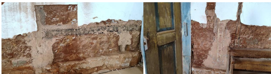
Legenda: Prospecções das alvenarias - Adobe Autoria: Francielle Ferreira Data: 10/04/2024
